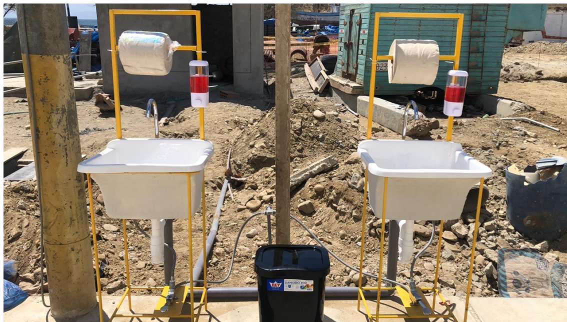
IMPLEMENTACION DE LAVADEROS EN OBRA
