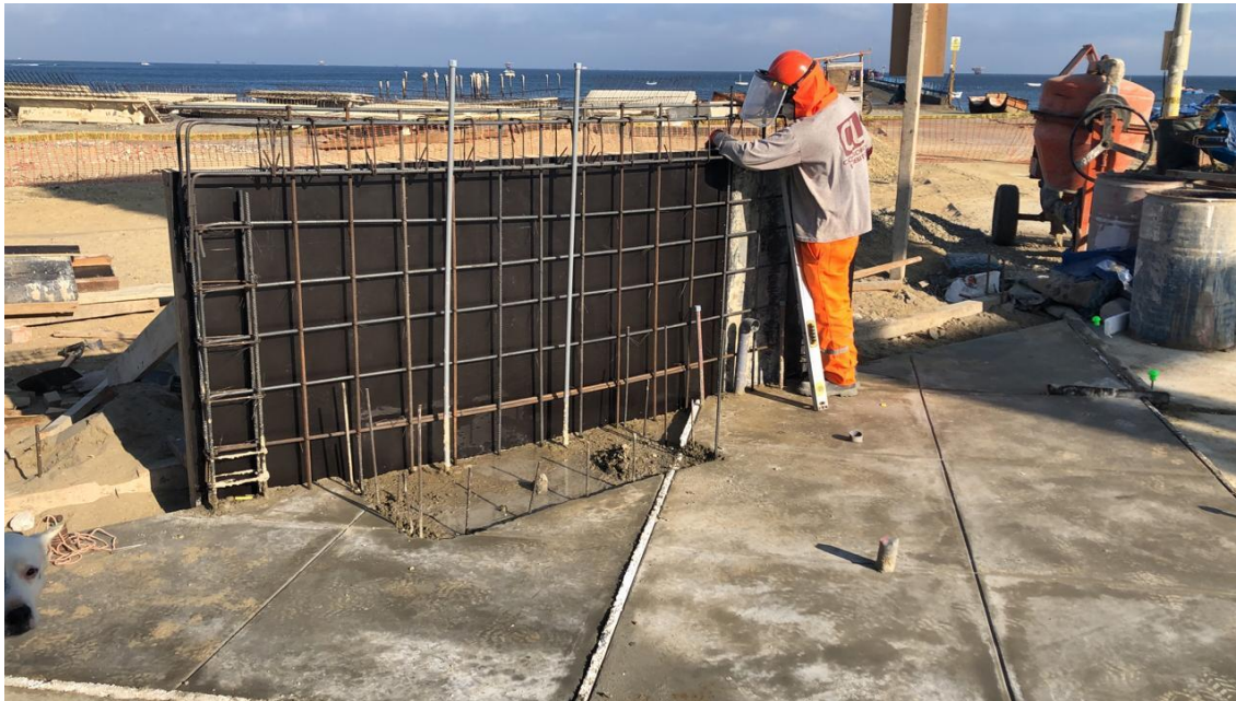
ARMADO DE ACERO Y ENCOFRADO PARA LAVANOTAS
