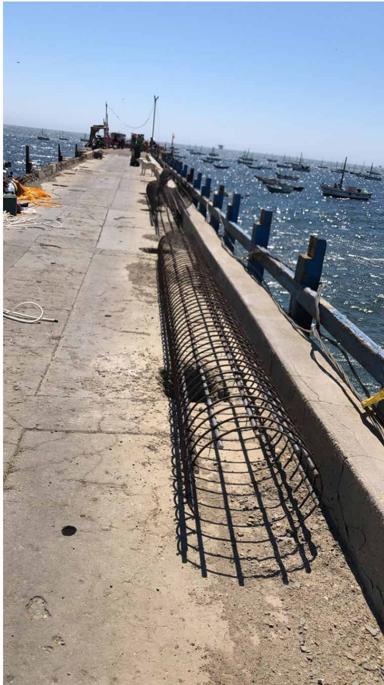
ACERO DE PILOTES, PREVIO AL ENCAMICETADO
