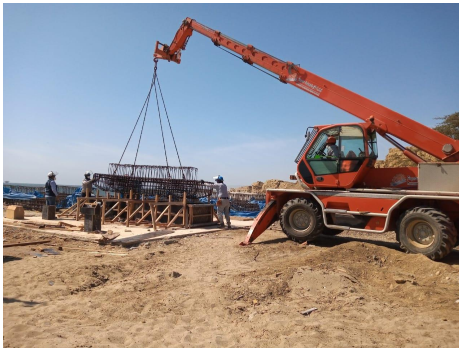
COLOCACION DE ACERO Y ENCOFRADO DE LOSA PREFABRICADAS
